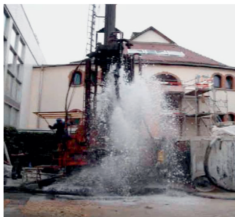
Unter Druck: artesische Fontäne durch eine Bohrung nach Mineralwasser für das Merkel'sche Bad in Esslingen 2005.
